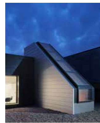
Edificio direzionale. Lucerna-riario disegnato dallo studio
